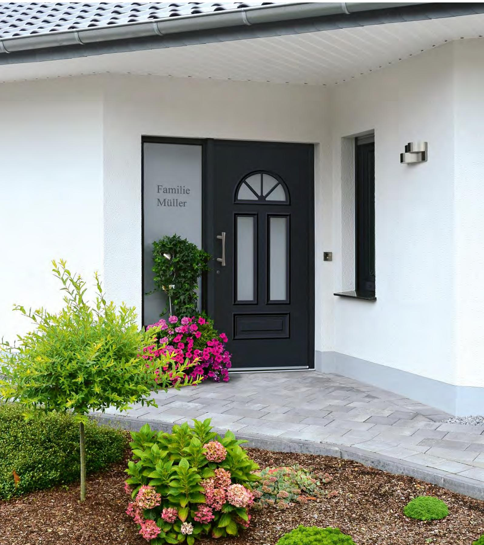
6448-25 mit Seitenteil | Farbe: RAL 7016 Anthrazitgrau | Glas: vollflächig mattiertes Glas | Griff: 5.100.03 Edelstahl | Bauart: Aufsatzfüllung |
